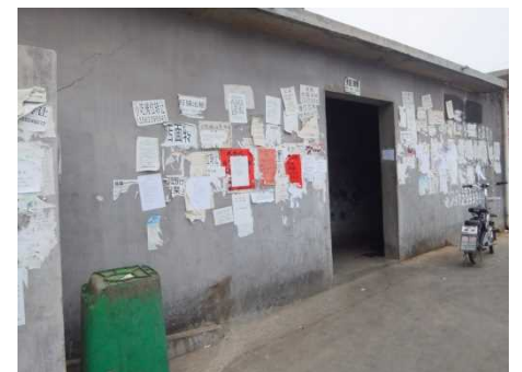
日照の公衆トイレ
